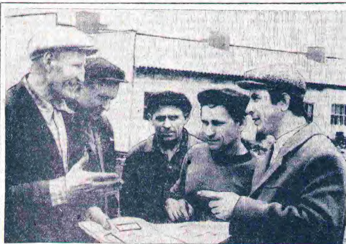
Бригада строителей ПМК 281, которой руководит В. Самойленко, по итогам первого квартала стала победителем социалистического соревнования. К Первомаю строители закончили кладку двух птичников на х. Красная Деревня.
