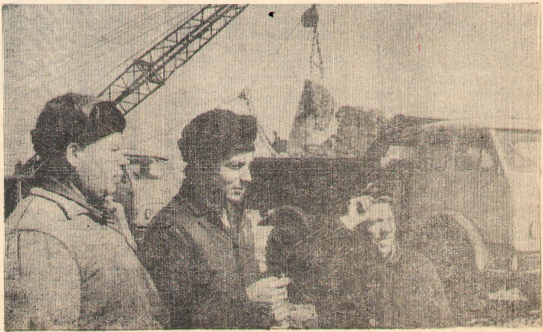
На снимке (слева направо): — экскаваторщик М. И. Коврежкин, шофер В. Надточный и помощник экскаваторщика В. А. Гусаченко. Фото П. Брызгуна.
