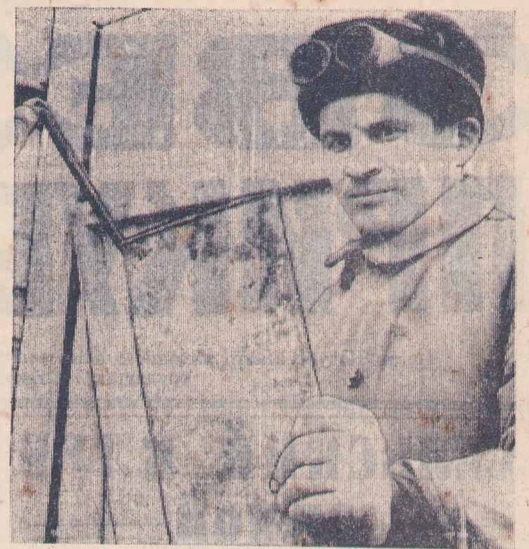
В послужном списке газозлектросварщика пятого разряда Алексея Александровича Багряшова из СМУ-3 работа по комсомольской путевке в Новокузнецке, на строительстве Новосибирской ТЭЦ. И везде, где бы он ни трудился, остался след его опытных рук. Ныне он выполняет задание на 110-115 процентов.
