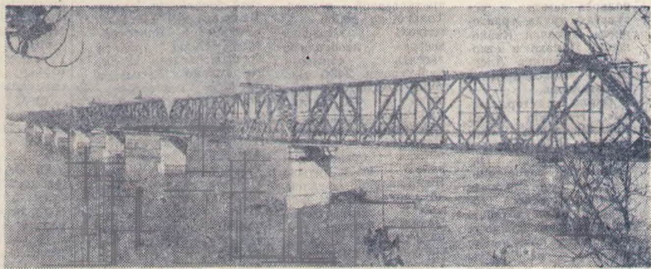
ХАБАРОВСКИЙ КРАЙ. На три месяца раньше срока завершено строительство крупнейшего железнодорожного моста через Амур в районе Комсомольска. Новый мост свяжет строящуюся Байкало-Амурскую магистраль с железной дорогой, идущей к Тихому океану. НА СНИМКЕ: мост через Амур. Фото А. Галушко. (Фотохроника ТАСС).
