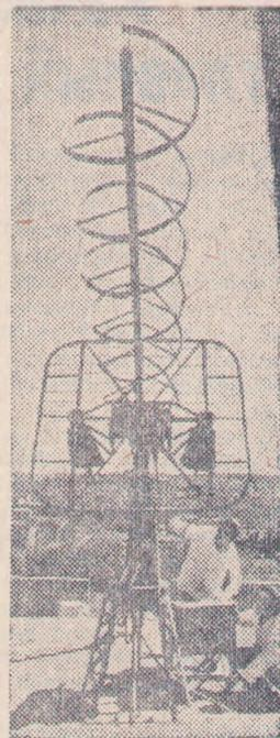
На снимке: антенна системы «Уран» готовится к приему информации со спутника «Метеор». Фото И. Давиташвили и М. Датикашвили
