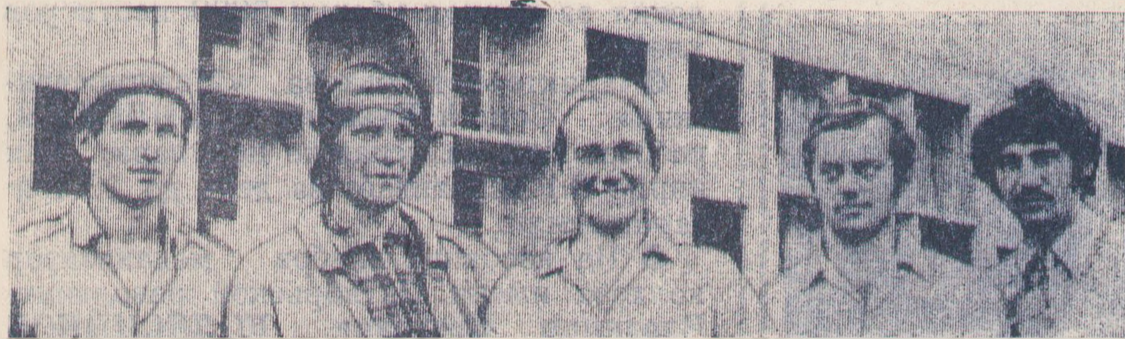
Члены бригады Героя Социалистического Труда А. Н. Шевченко из СМУ-1 (на снимке слева направо) Н. М. Ерофеев, В. Н. Реснянский, А. Н. Комякова, А. Я. Подчернин, Н. В. Лаврик со своими товарищами за 18 дней произвели монтаж 36-квартирного крупнопанельного дома в селе Кочубеевском.
